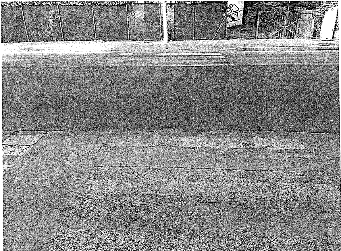
Immagini 2 e 3: stato dell'attraversamento ciclopedonale di giorno dopo l'asfaltatura del 16 luglio
