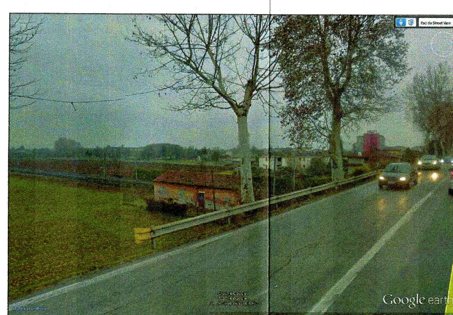
6 - FABBRICATO DA DEMOLIRE
