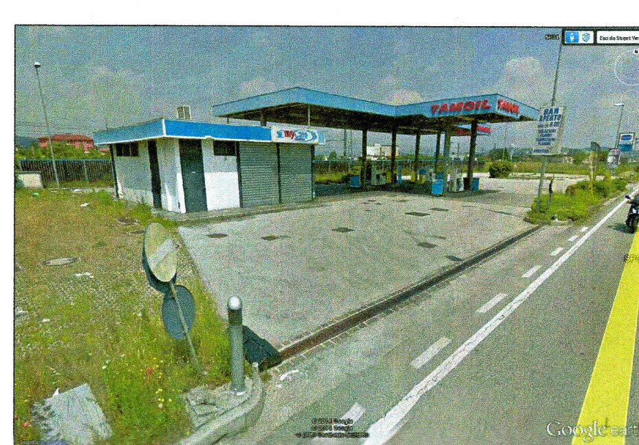
22 - FABBRICATO DA DEMOLIRE
