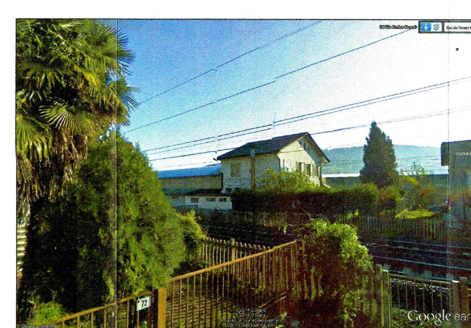
9 FABBRICATO DA DEMOLIRE
