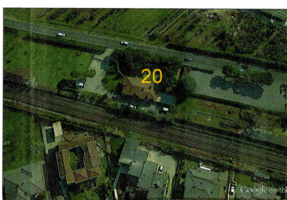
20 - FABBRICATO DA DEMOLIRE
