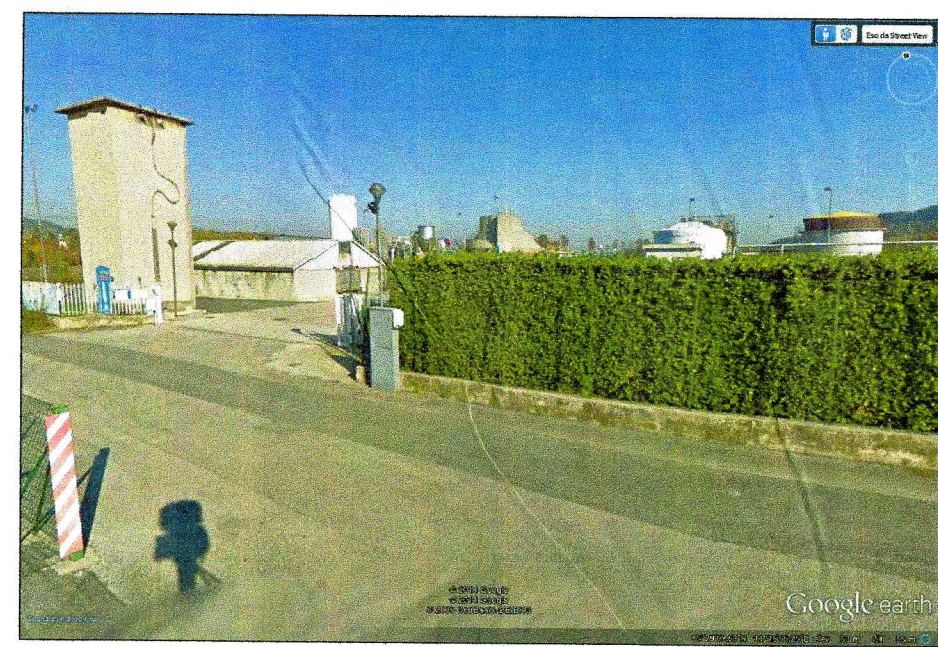
3 - FABBRICATO DA DEMOLIRE
