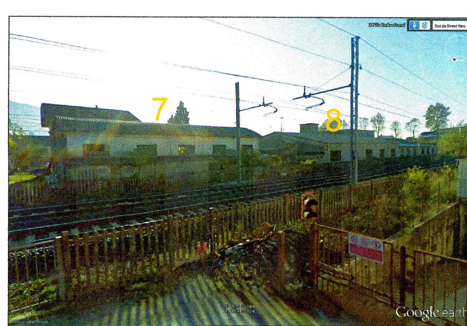
7-8 FABBRICATI DA DEMOLIRE
