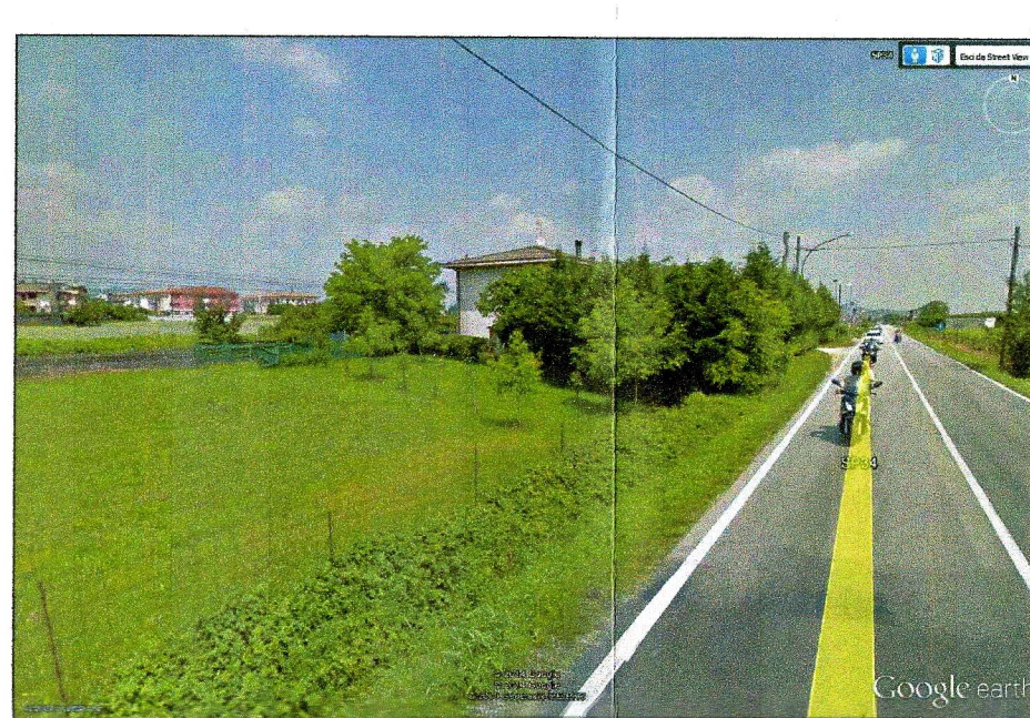
21 - FABBRICATO DA DEMOLIRE
