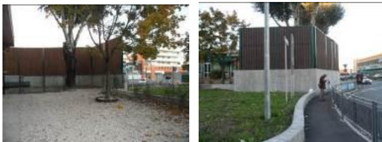
Figura 2 – Barriera antirumore (Scuola "Lattes")
