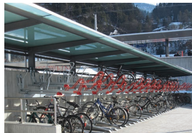
Nuovi stalli per bici alla stazione di Brixlegg Neue Radständer am Bahnhof Brixlegg
