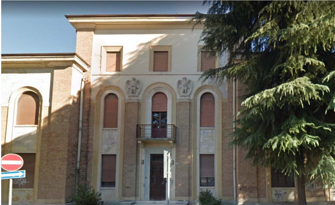
Particolare dell'ingresso (fonte Google maps – street view)
