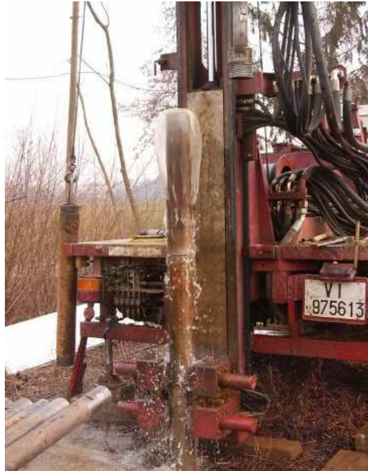
Figura 14. Falda idrica in pressione a -34m dal p.c. Dalla campagna geognostica per lo studio geologico per la variante alla S.P.46 VICENZA-ISOLA V.NA
