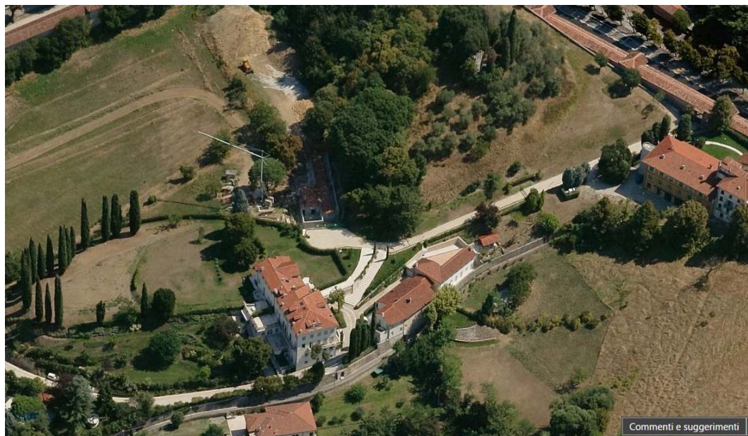
Immagine 2 – Panoramica aerea (dettaglio degli immobili ricadenti nel complesso)
