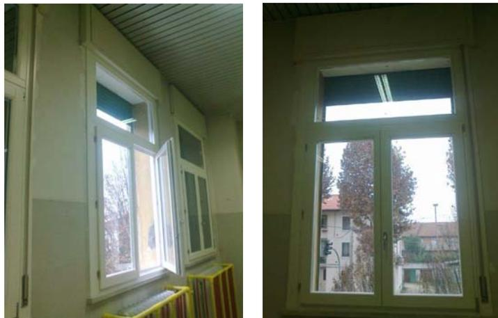
**Figura 12: Immagini delle finestre ad elevato potere fonoisolante installate presso la Scuola Elementare Cabianca**
