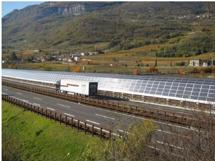
**Figura 6: Installazione di barriere acustiche munite di moduli fotovoltaici lungo l'autostrada A22 "del Brennero" [17]**
