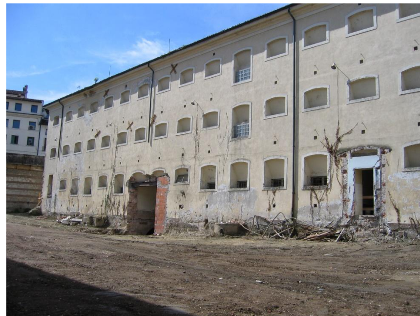
Veduta corte interna porzione ex Carcere Giudiziario
