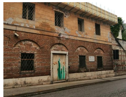
FOTO 4 Facciata lato Sud
