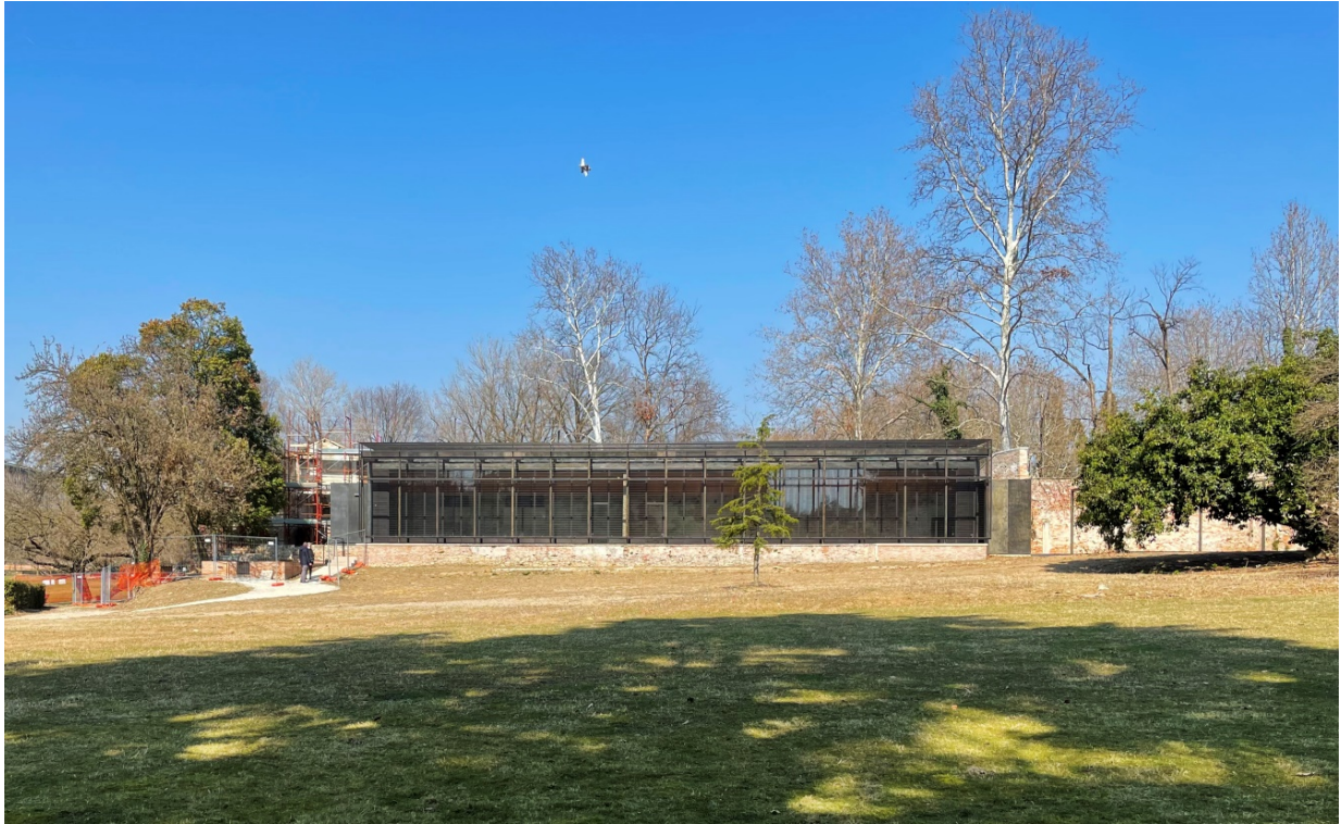
vista complessiva delle ex Serre dopo l'ultimazione dei lavori
