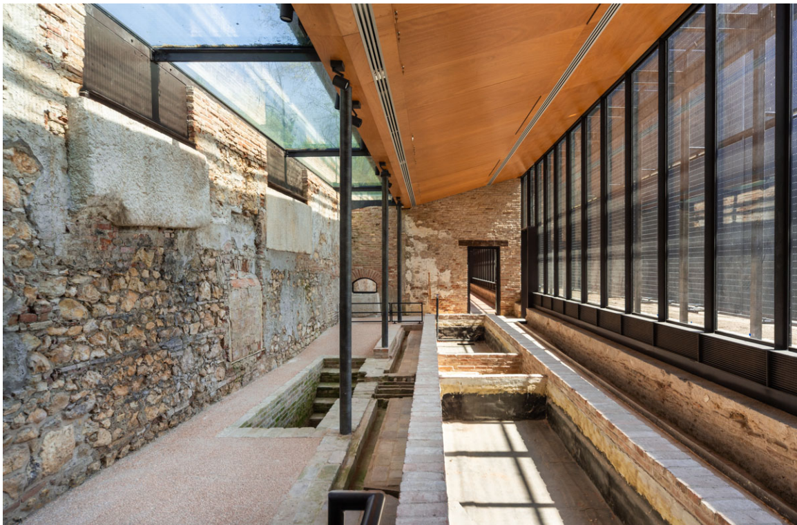
Serra calda dopo l'ultimazione dei lavori
