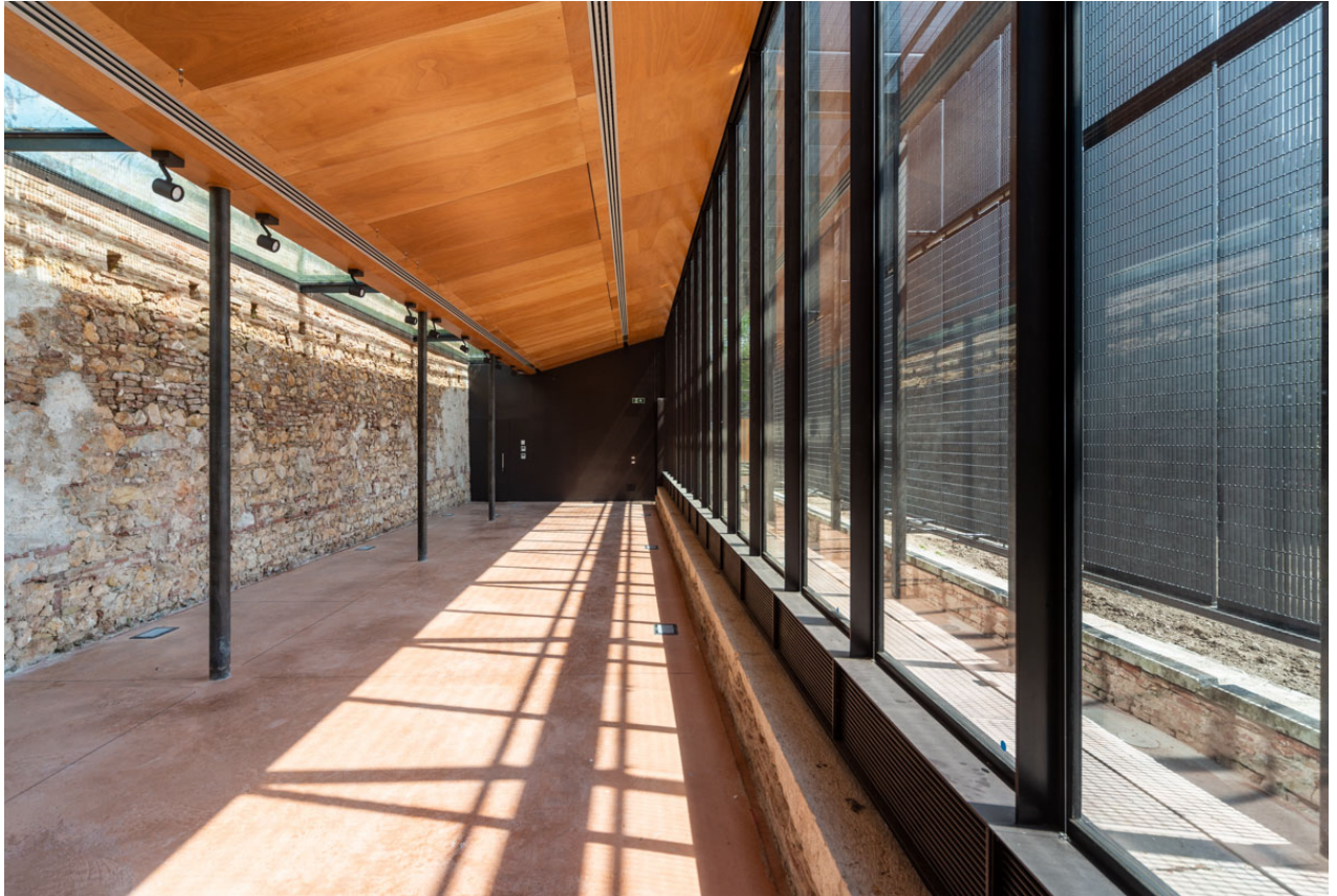
Serra fredda dopo l'ultimazione dei lavori
