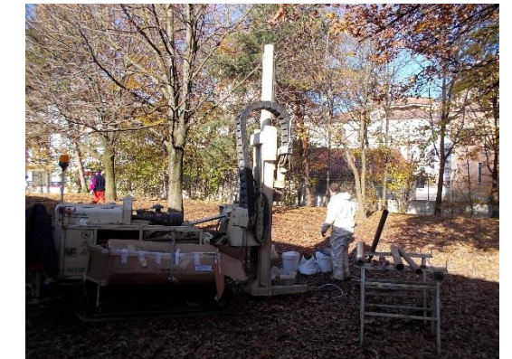
Esecuzione del sondaggio SG2
