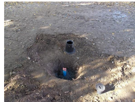
Sonda soil-gas completata
