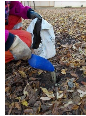
Sigillatura del foro S3 con bentonite granulare
