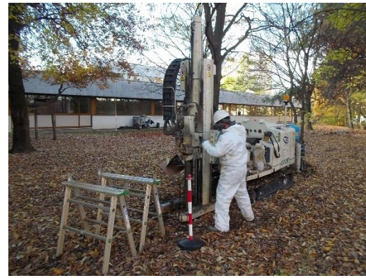
Esecuzione del sondaggio S3
