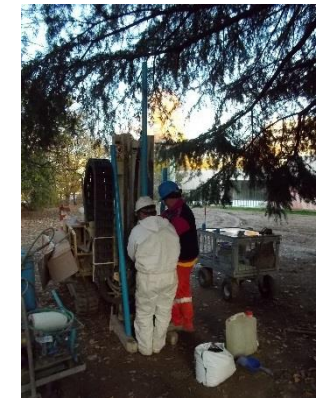
Completamento del piezometro MW1
