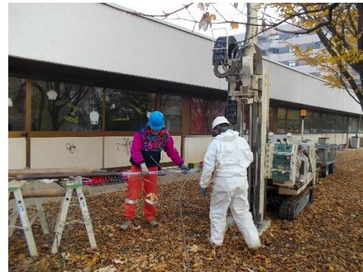
Esecuzione del sondaggio MW3
