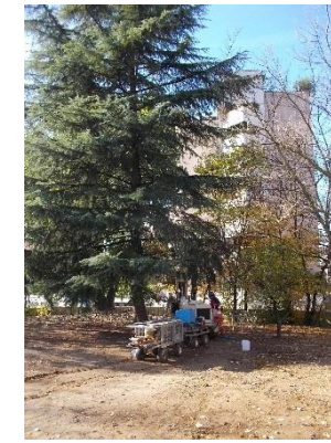
Esecuzione del sondaggio MW1
