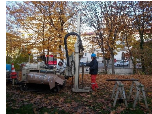
Esecuzione del sondaggio SG1
