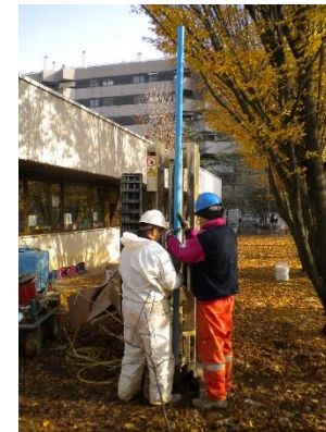
Completamento del piezometro MW3
