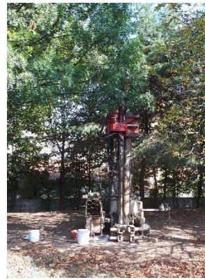
Esecuzione del sondaggio S2
