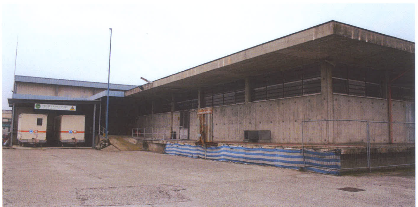
Lato sud del fabbricato principale (9)
