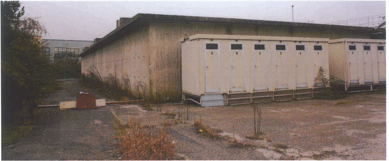
Depuratore lato est (4) I blocchi servizi non sono della proprietà
