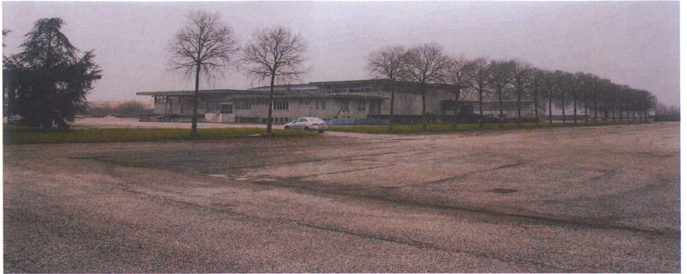
Panoramica dal punto 10
