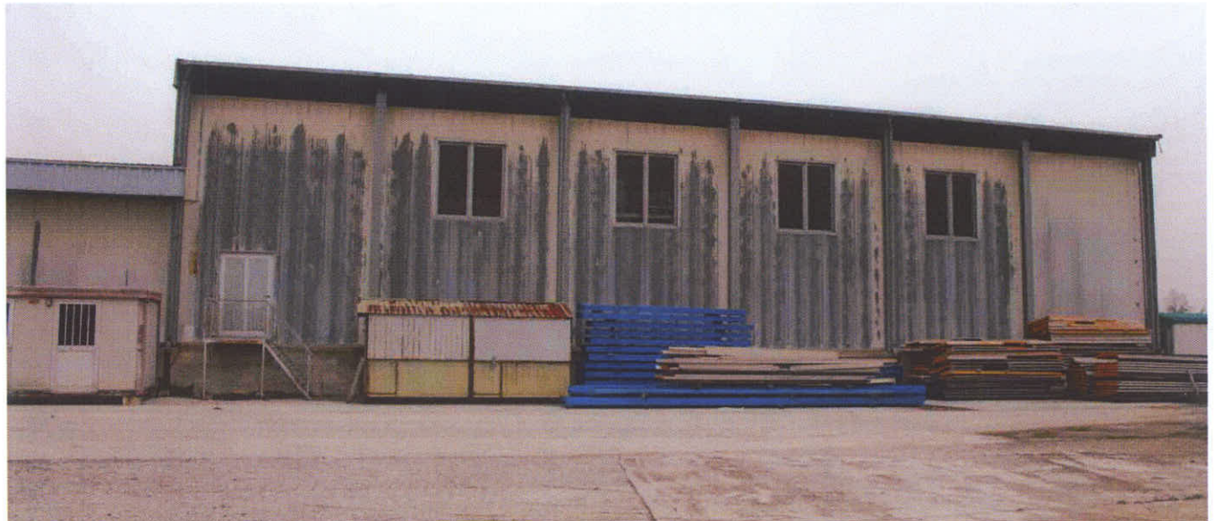
Lato ovest - retro del fabbricato con struttura in ferro (9)
