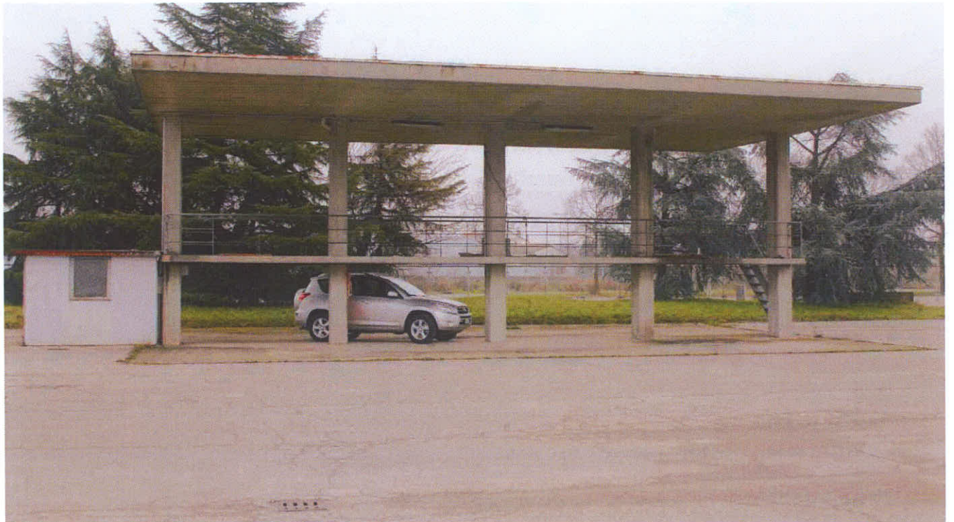
Fabbricato fronte strada lato ovest lavaggio (3)
