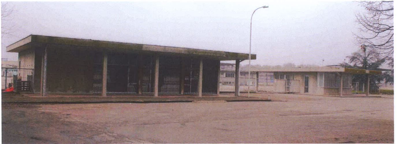
Fabbricati fronte strada lato est panoramica (1-2)
