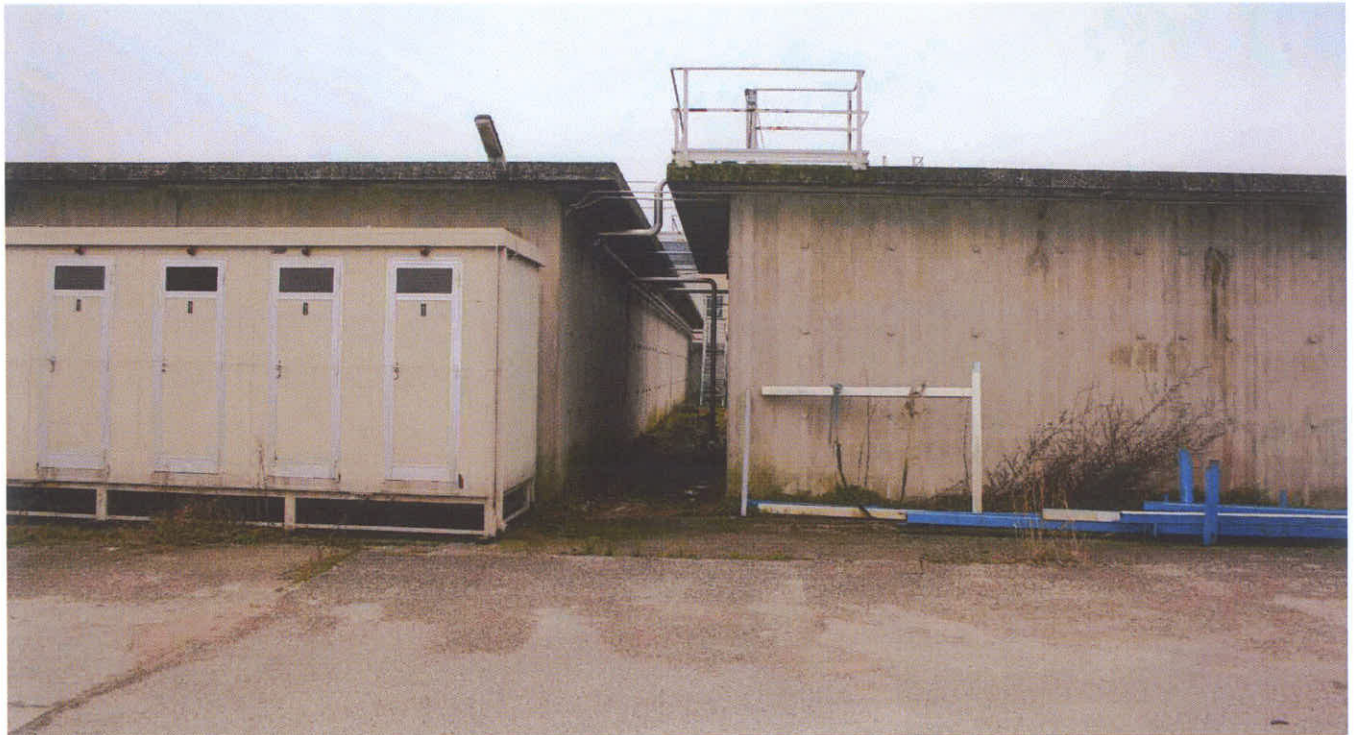
Depuratore lato est (4) Corridoio tra le due vasche
