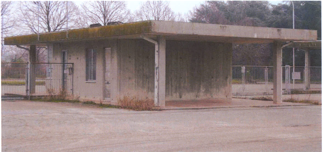
Fabbricato fronte strada ingresso lato ovest (1)
