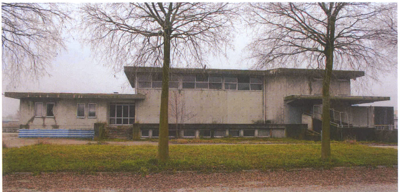
Lato nord - retro del fabbricato principale (9) si noti l'interrato
