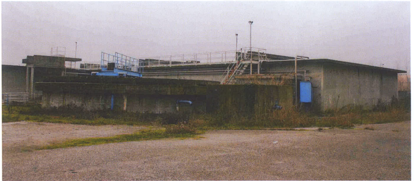
Depuratore lato sud (4)
