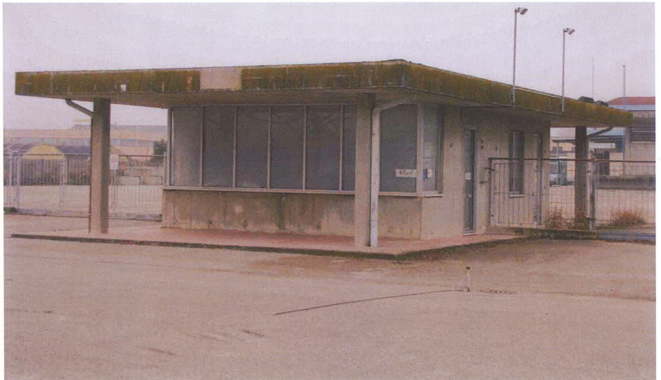
Fabbricato fronte strada ingresso lato est (1)
