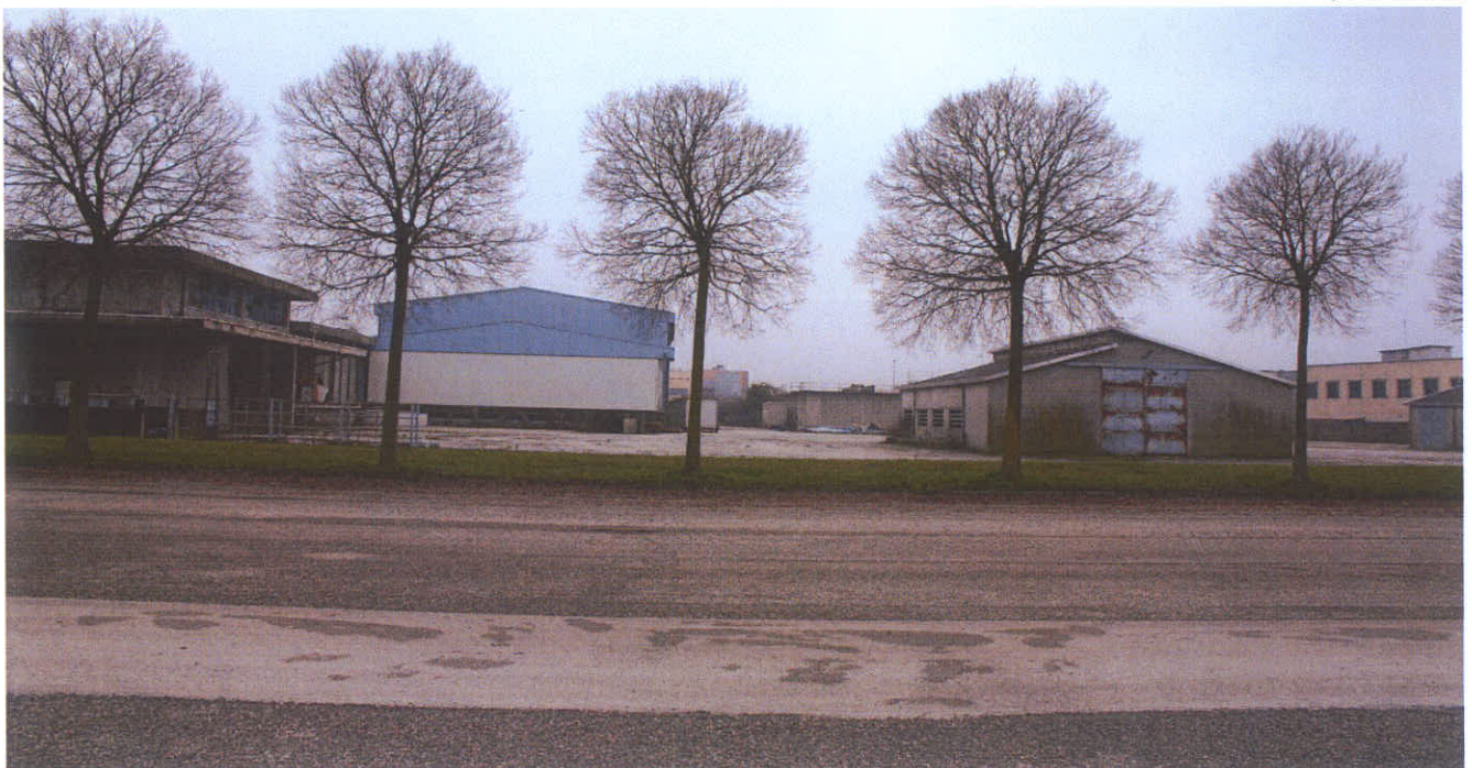
Panoramica dal punto 12
