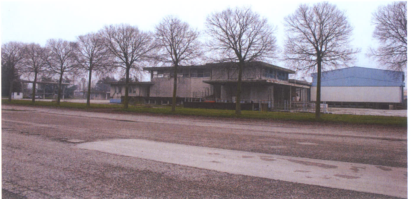
Panoramica dal punto 13
