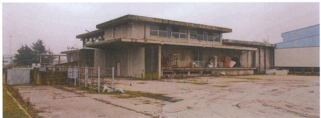
Lato ovest - retro del fabbricato principale (9)
