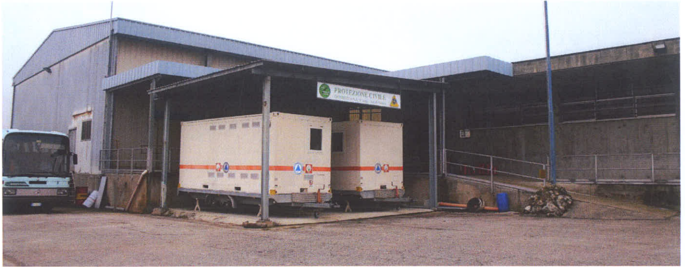
Lato sud ed est del fabbricato adiacente al principale (9) con struttura in ferro
